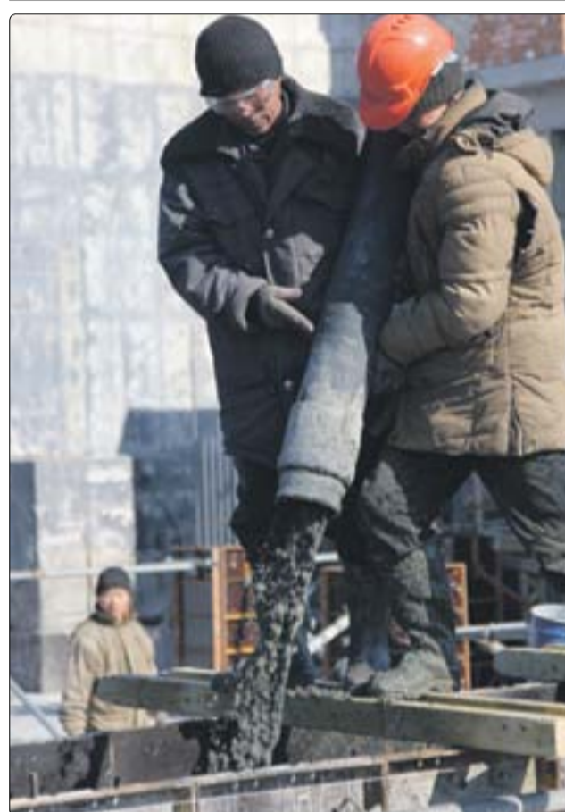
■ Заливка раствором стилобатной части. Целый день на стройку шли машины с бетоном.
