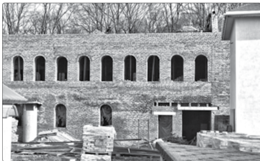
■ Возводится здание церковно-причтового дома в Покровском приходе
